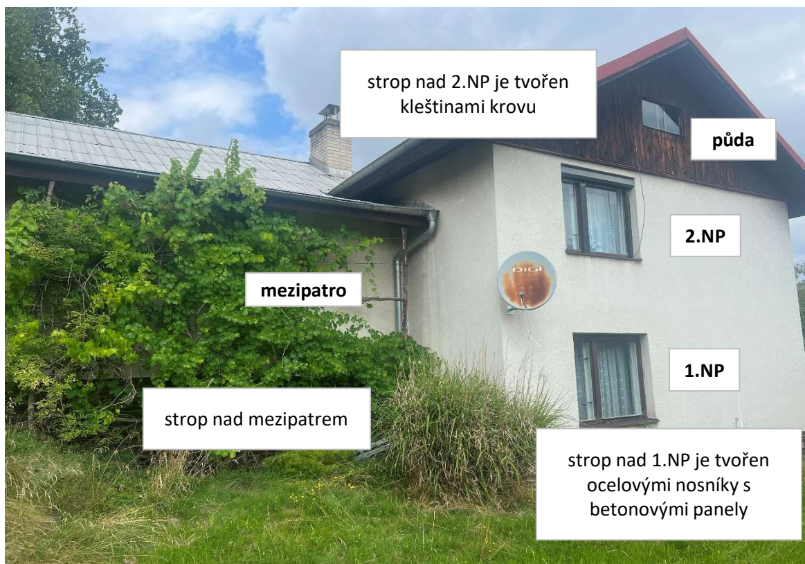
Pohled na objekt
