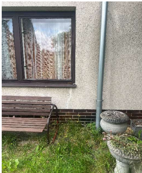
Trhlina v parapetu 1.NP
