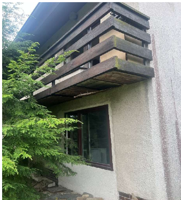
Pohled na balkon
