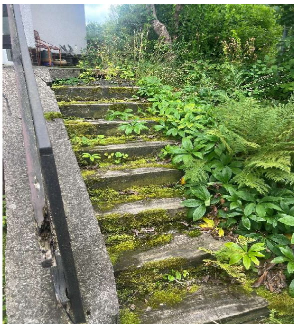
Dřevěné schodiště v exteriéru
