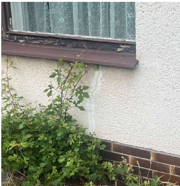
Trhlina v parapetu 1.NP
